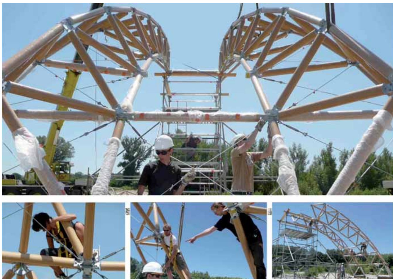
Rys. 4. Montaż kładki bez użycia ciężkiego sprzętu
