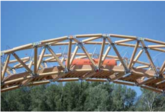
Rys. 6. Próbné obciążenie kładki zbiornikami z wodą
