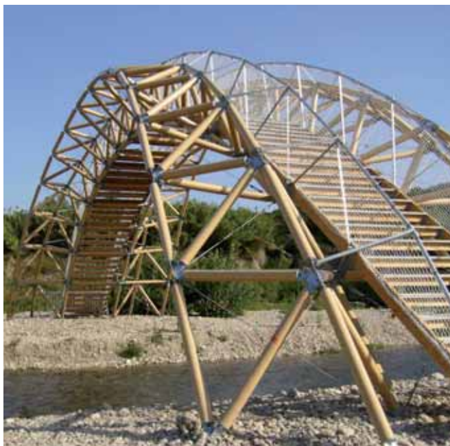
Rys. 8. Widok gotowego obiektu
