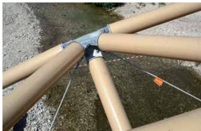
Rys. 5. Węzeł kratownicy przestrzennej
