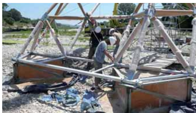
Rys. 3. Fundamenty kładki ukształtowane w postaci skrzyń ze sklejki (wzmocnionej stalowymi kątownikami) wypełnionych kamieniami
