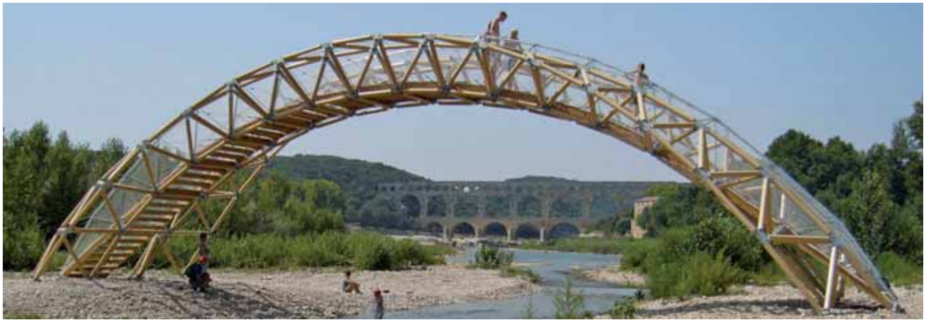
Rys. 6. Kładka z kartonu – nowy Pont du Gard
