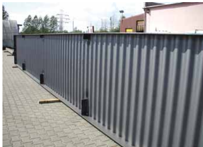
Rys. 1. Fragment dźwigara z falistym  rodnikiem
