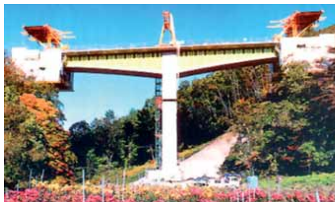
Rys. 4 a. Hondani Bridge, Japonia. Widok podczas budowy
