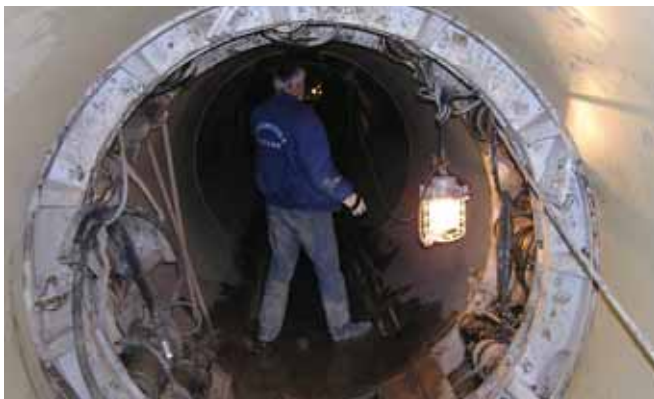
Stacja pośrednia – widok od wewnątrz
