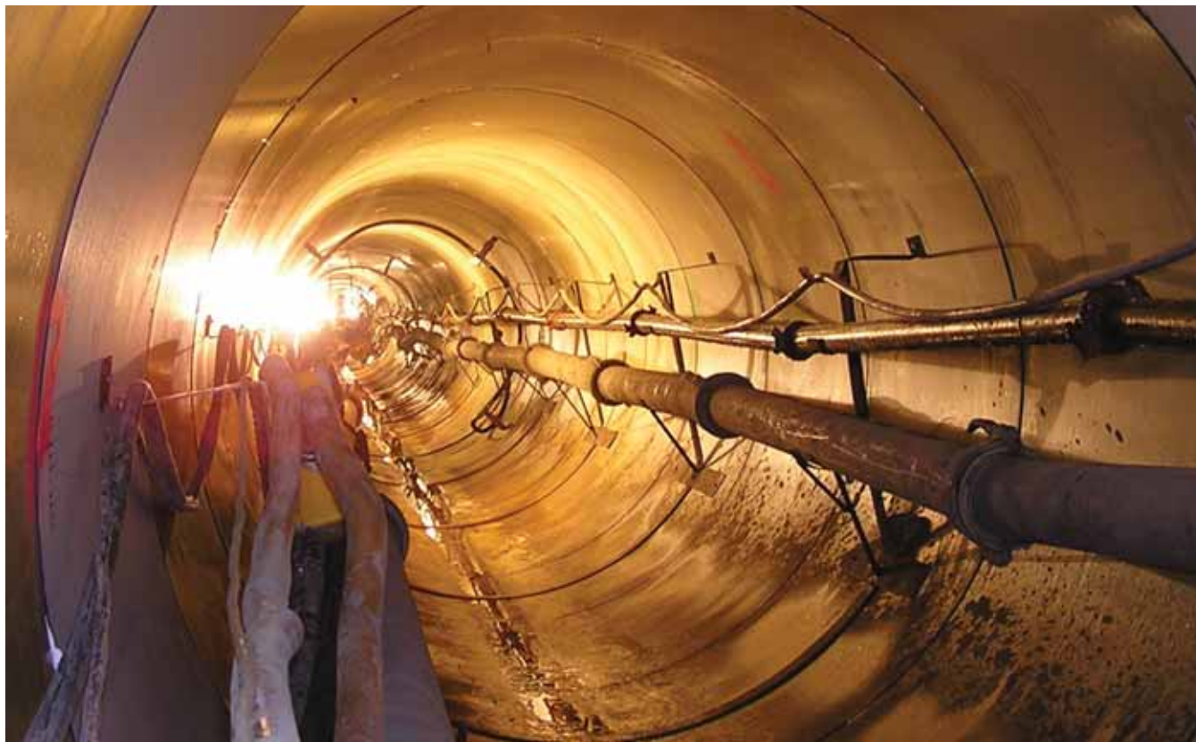
Rurociąg w trakcie mikrotunelowania – widok rurociągów płuczkowych oraz podłączenie instalacji smarowania
