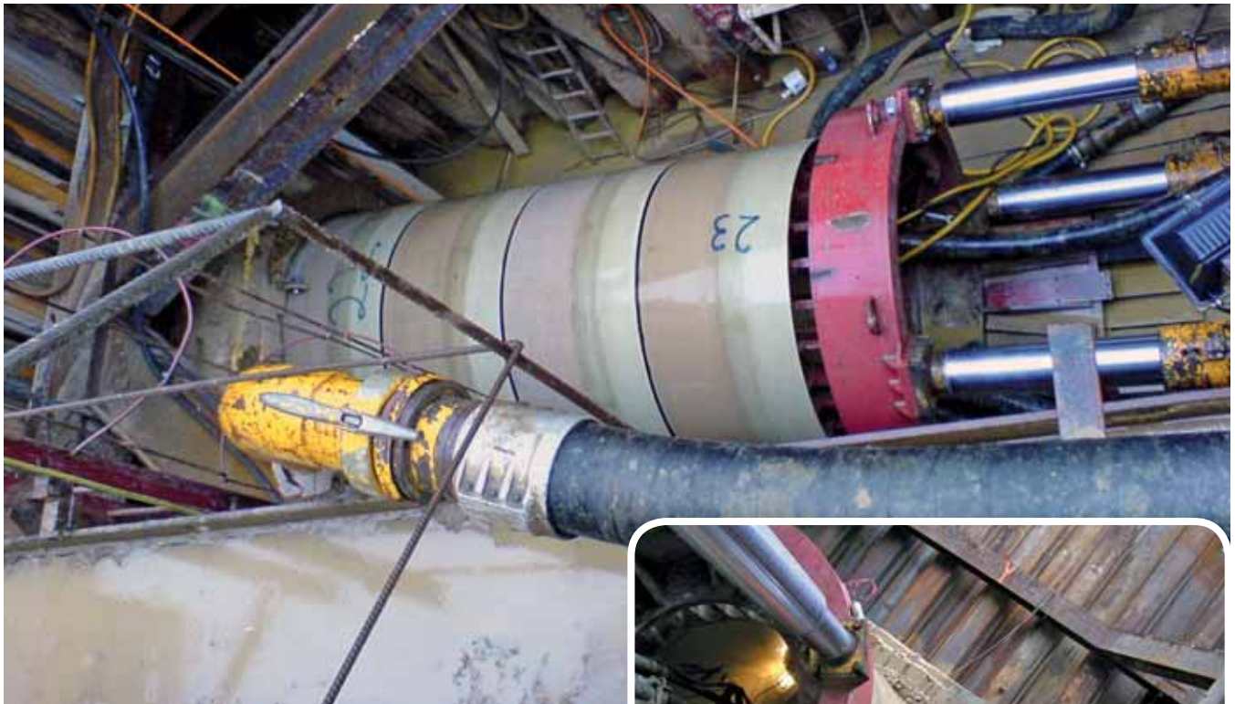
Widok komory startowej – montaż rur o długości 1 m
