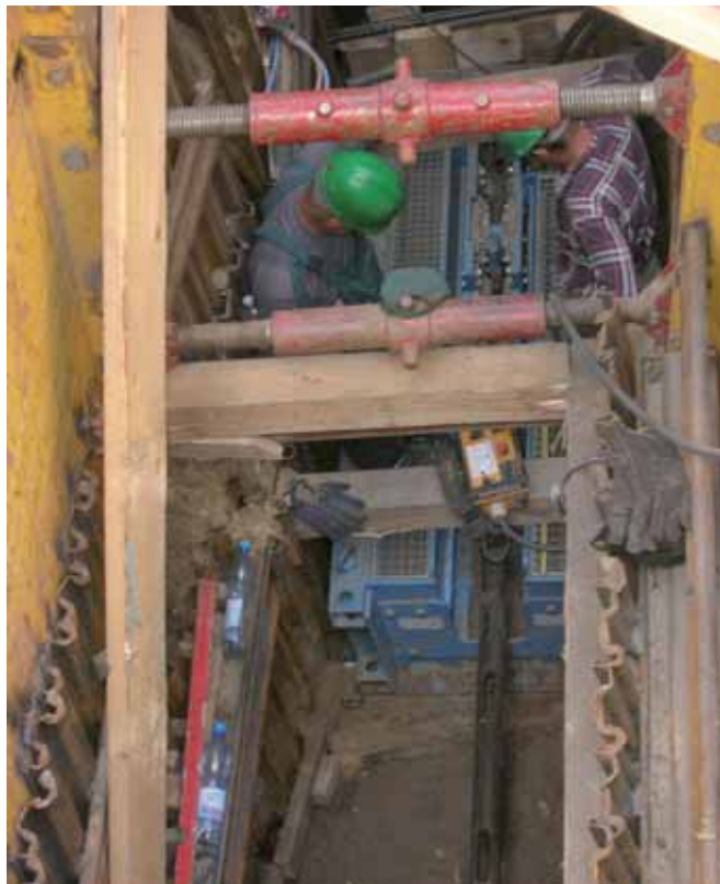
Laweta GrundoBURST zainstalowana w wykopie maszynowym
