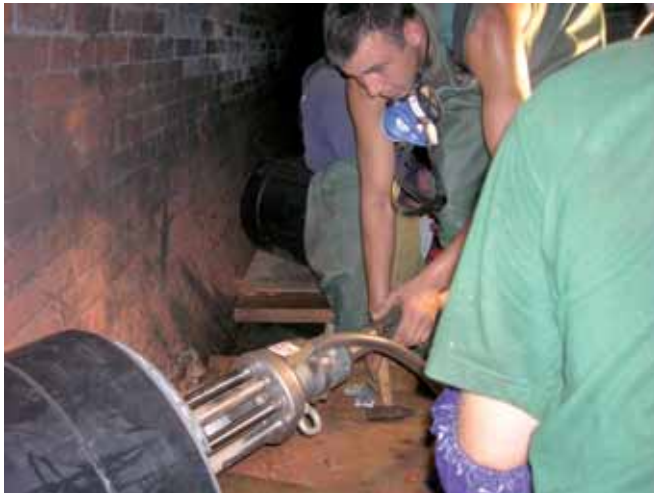
Montaż rur modułowych z systemem Burstfix
