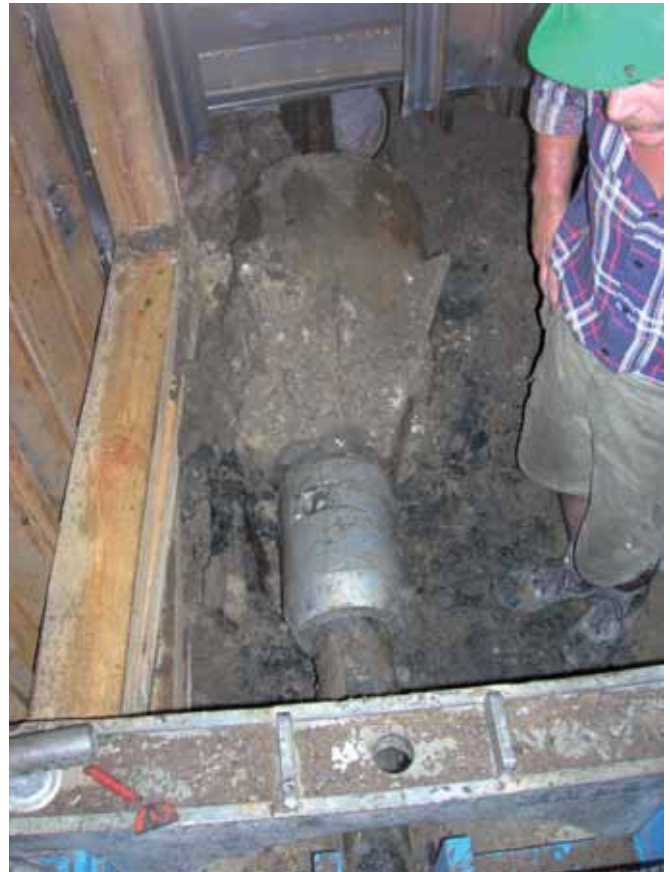
Głowica poszerzająca z wciągniętymi modułami
