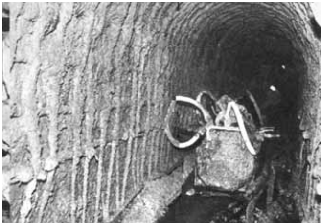
Prace zabezpieczające w kolektorze pod ul. Franciszkańską w Krakowie, fot. J. Chmura
