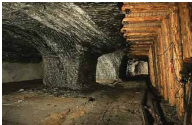
Adaptacja starej komory składu materiałów wybuchowych na pomieszczenia sanatoryjne w Kopalni Soli „Bochnia”, z archiwum Kopalni Soli „Bochnia”
