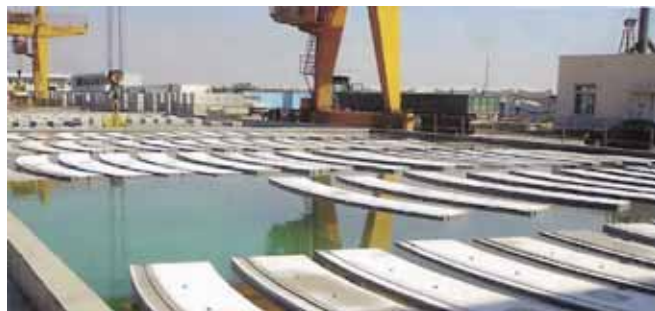
Rys. 5. Dojrzewające segmenty w zbiorniku z wodą w zakładzie prefabrykacji [1]
