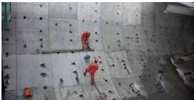
Rys. 4. Zamontowane segmenty obudowy tunelu [1]
