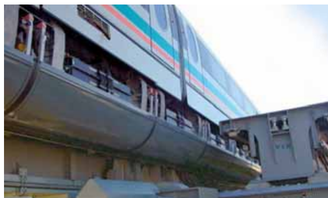
Rys. 8. Widok konstrukcji rozjazdu z napędem
