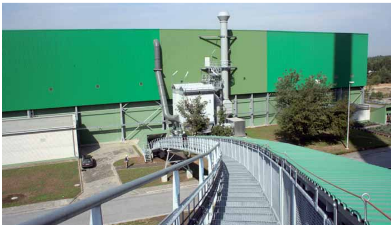
Widok na nowy magazyn paliw alternatywnych z galerii przenośnika transportującego paliwa, fot. archiwum Górażdże Cement SA
