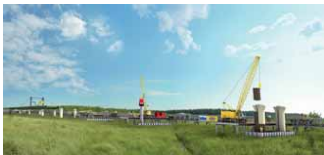
Budowa mostu z wykorzystaniem mostu technologicznego (rozwiązania nieralizowane)
