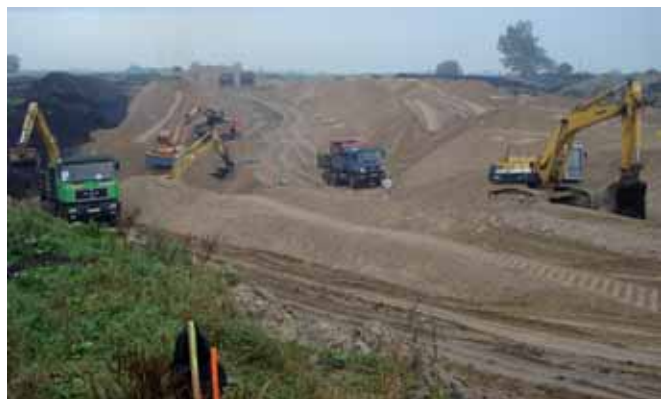
Wymiana gruntu do 12 m głębokości w km 13+036 – 13+212. Wymiana gruntu w trakcie wykonywania
