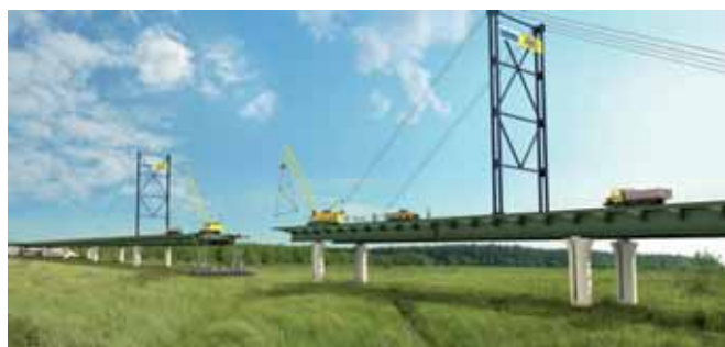
Budowa podpory z lewej strony i nasuwanie konstrukcji z prawej strony
