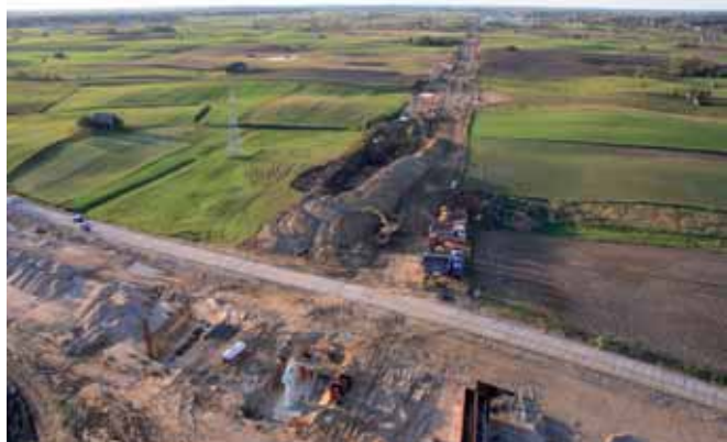
Budowa wiaduktu nr 11 w ciągu drogi krajowej nr 16. Wiadukt nr 11 w km 15+052 obwodnicy Augustowa. Na planie fundamenty i zbrojenie podpór wiaduktu, objazd tymczasowy z płyt drogowych, hałdy gruntu z wykopu przeznaczony do wbudowania w nasyp
