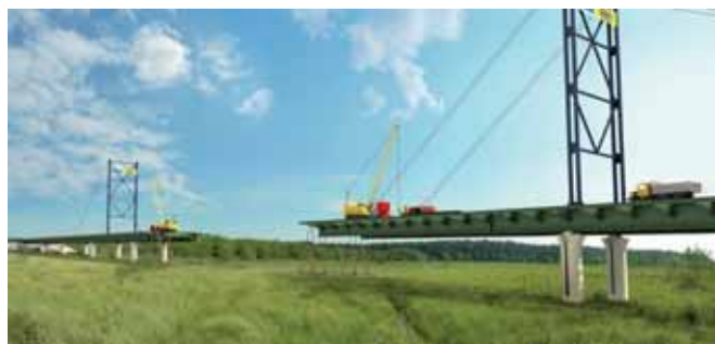
Początkowa faza budowy podpór mostu z lewej i prawej strony
