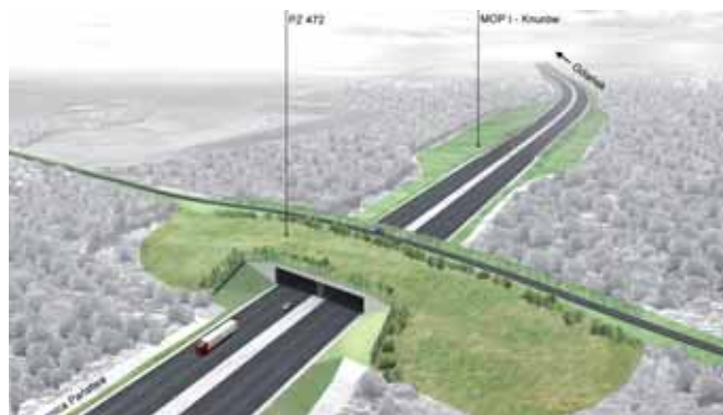
Wizualizacja wiaduktu/przejęcia dla zwierząt PZ 472 nad autostradą A1, o konstrukcji betonowej, sprężonej
