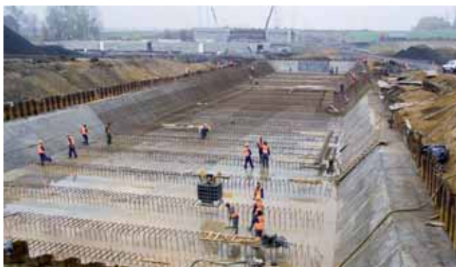
Fot. GDDKiA Oddział w Katowicach
