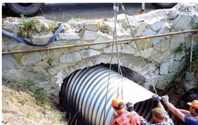
Rys. 13. Wzmacnianie istniejącej konstrukcji przepustu metodą rura w rurę [5]
