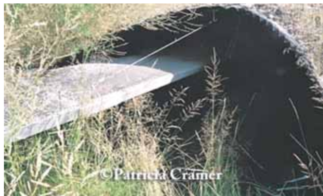
Rys. 5. Przykład małego przepustu wyposażonego w półki dla zwierząt [12]
