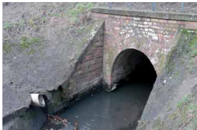
Rys. 1. Przykład tradycyjnego przepustu wykonanego z cegły, fot. A. Wysokowski
