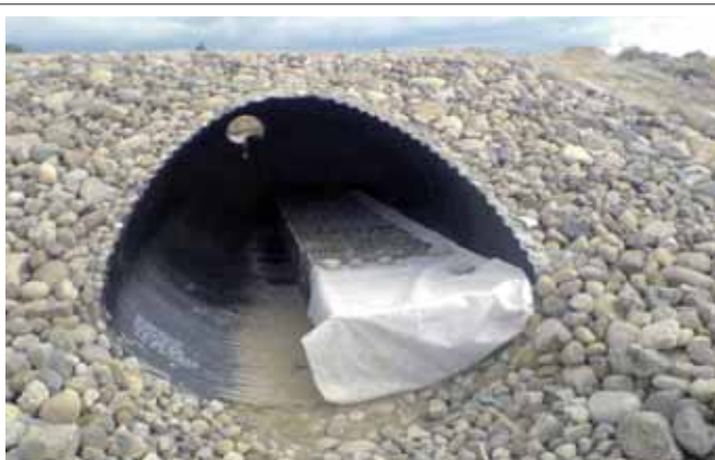
Rys. 11. Półka dla płazów wykonana wewnątrz przejścia dla małych zwierząt, fot. ViaCon
