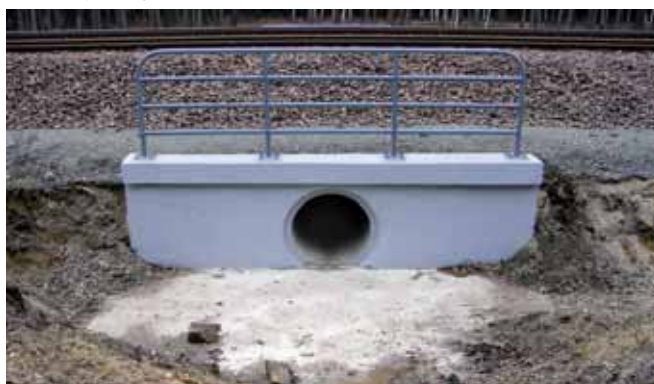
Rys. 10. Typowa głowica czołowa w przepuscie pod linią kolejową, fot. Z. Kubiak
