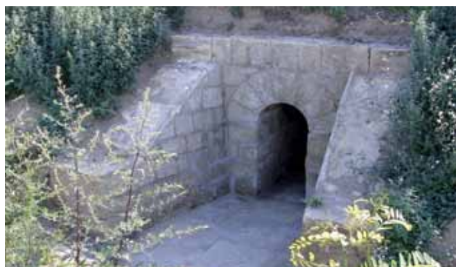
Rys. 2. Przykład tradycyjnego przepustu wykonanego z ciosów kamiennych, fot. Z. Kubiak
