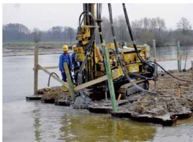
Ryc. 10. Posadowienie mostu na Warcie, widok na obie podpory mostu przy wysokim stanie wody
