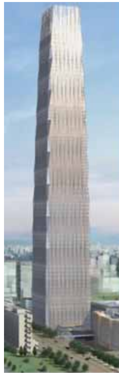
Rys. 12. Konstrukcja ramowo-rurowa Beijing International Trade Center IIIA; 74 piętra, 330 m wysokości
