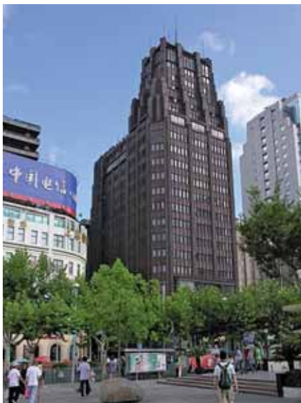
Rys. 1. Shanghai Park Hotel – pierwszy budynek o stalowej konstrukcji nośnej w Chinach (1932); posiada 22 piętra i 82 m wysokości
