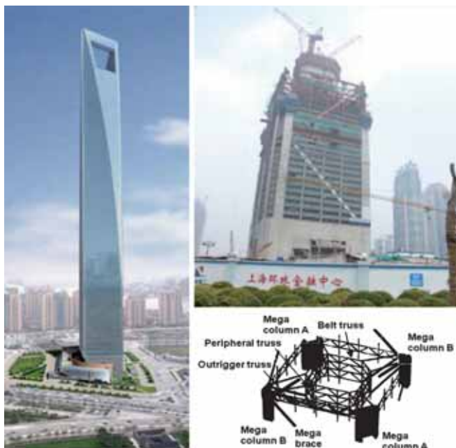
Rys. 10. Shanghai World Financial Center – konstrukcja mieszana żelbetowo-stalowa; 101 pięter, 492 m wysokości
