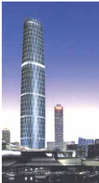
Rys. 9. Guangzhou (Kanton) Zhujiang Western Tower – przykład wież o konstrukcji rurowej; 103 piętra, 432 m wysokości
