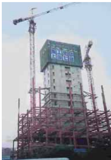
Rys. 16. Stalowo-żelbetowa konstrukcja mieszana jako wynik badań obiektu o wysokiej odporności sejsmicznej
