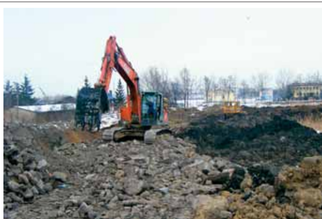
Stabilizacja lagun gruzem, fot. archiwum ABM SOLID SA
