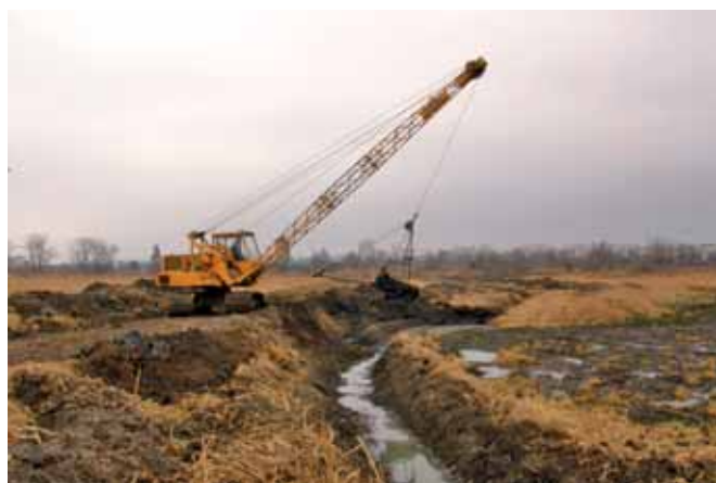
Wykonanie systemu rowów odwadniających złoże lagun, fot. archiwum ABM SOLID SA
