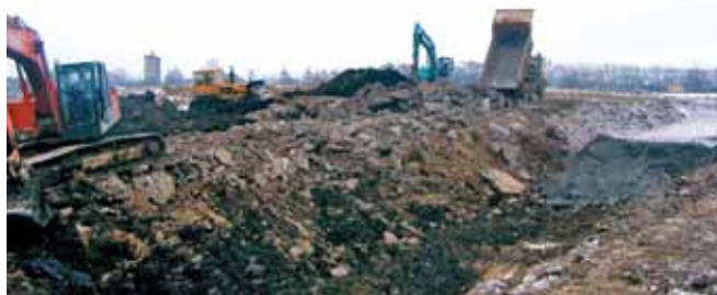
Stabilizacja podłoża i przygotowanie podłoża pod budowę nasypu walu z itu, fot. archiwum ABM SOLID SA
