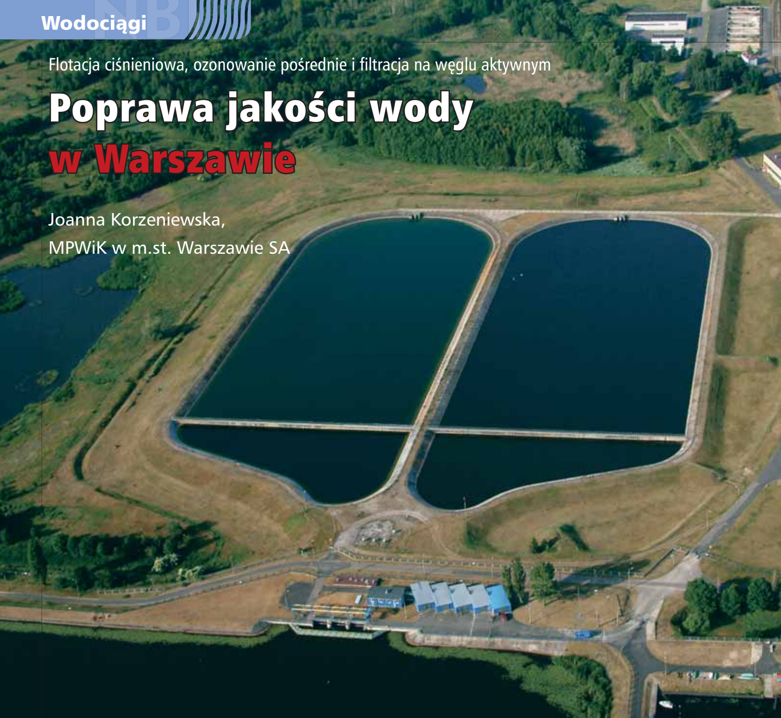
Zakład Wodociągu Północnego w Wieliszewie, fot. Jacek Maria Jeliński
