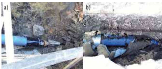
Przykłady zastosowania rur PE z warstwami ochronnymi w pipe bursting
