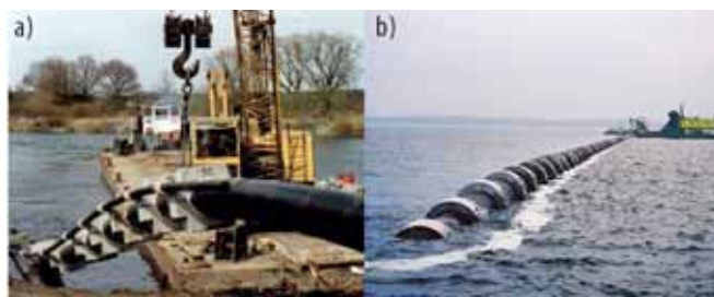
Przykłady zastosowania swobodnego zatapiać rur polietylenowych w rzece i otwartym morzu: a) przekroczenie rzeki, b) zatapiać wylotu morskiego
