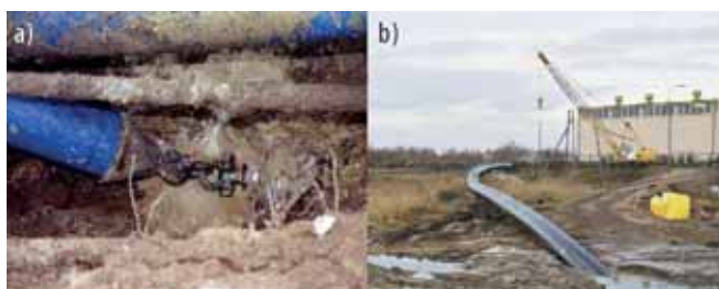
Przykłady zastosowania rur z tworzyw sztucznych w technologii HDD – przewiert horzontalny: a) rura polietylenowa z powłoką ochronną, b) rura polietylenowa DN 1200 mm standardowa
