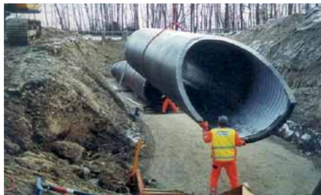
Montaż przepustu drogowego z rury strukturalnej
