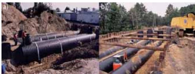
Przykłady zbiorników wykonanych z rur z tworzyw sztucznych: a) zbiorniki pojedyncze, b) układ połączonych zbiorników
