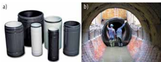
Przykłady zastosowania technologii bezwykopowej do renowacji krótkimi odcinkami rur z tworzyw sztucznych: a) moduły do renowacji wykonane z rur pełnościennych, b) wykonywanie renowacji modułami z rur strukturalnych
