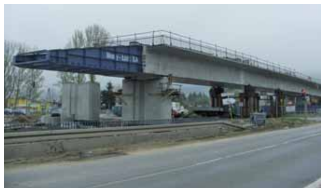
Budowa estakady w Myślenicach
