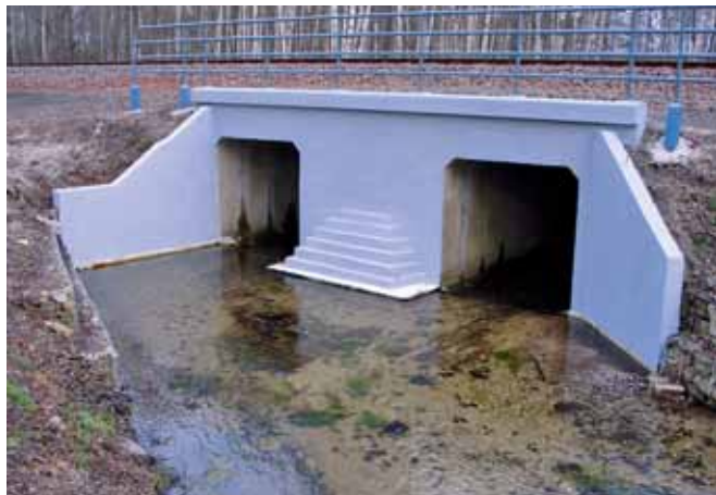
Rys. 4. Dwukomorowy ramowy przepust kolejowy o konstrukcji żelbetowej, fot. Z. Kubiak
