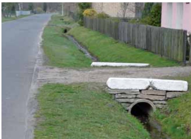
Rys. 7. Przykładowe przepusty pod zjazdami gospodarczymi z drogi kołowej, fot. A. Wysokowski
