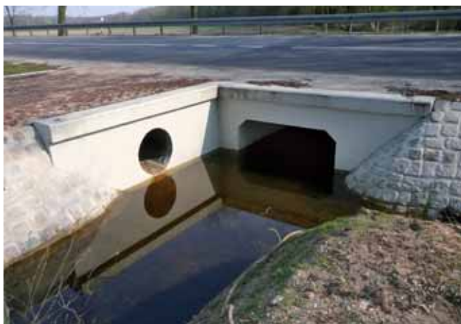
Rys. 6. Jednokomorowy ramowy przepust drogowy o konstrukcji żelbetowej. Widoczne jest prawidłowe utrzymanie konstrukcji przepustu, jednakże poważne zastrzeżenia budzi brak drożności cieku wodnego, fot. A.Wysokowski
