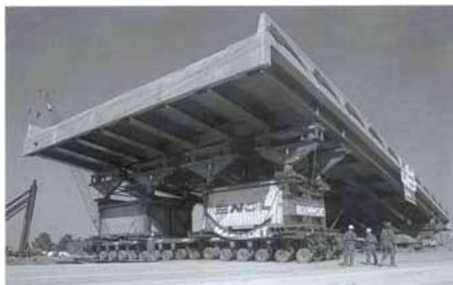
Rys. 1. Przewóz mostu modułowym transporterem SPMT
