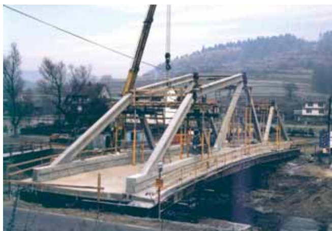
Rys. 3. Most łukowy w czasie montażu
