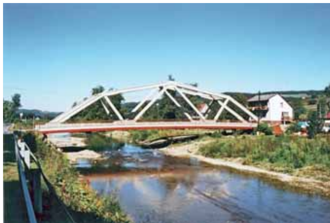
Rys. 2. Typowy most łukowy z elementów prefabrykowanych
