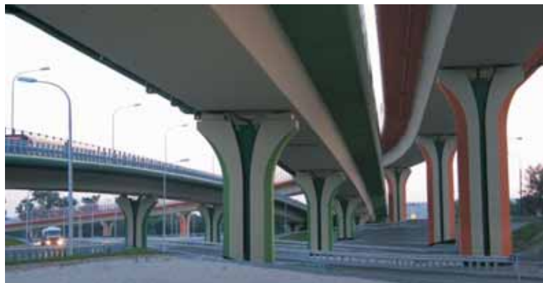
Trasa Siekierkowska, Warszawa - posadowienie na palach prefabrykowanych wbijanych
