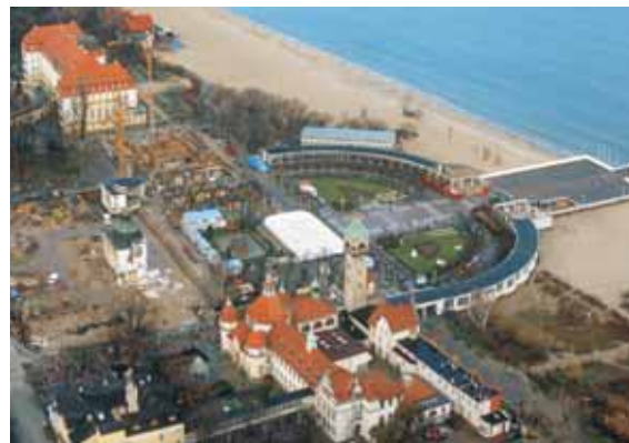
Sopot - zabezpieczenie wykopu ścianką szczelną wciskaną
