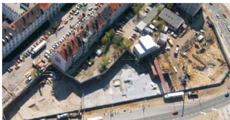
Grunwaldzki Center, Wrocław - zabezpieczenie wykopu głębokiego ścianką szczelną
