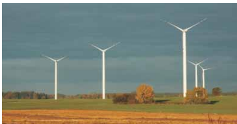
Farma wiatrowa w Karścinie - posadowienie na palach prefabrykowanych wbijanych
