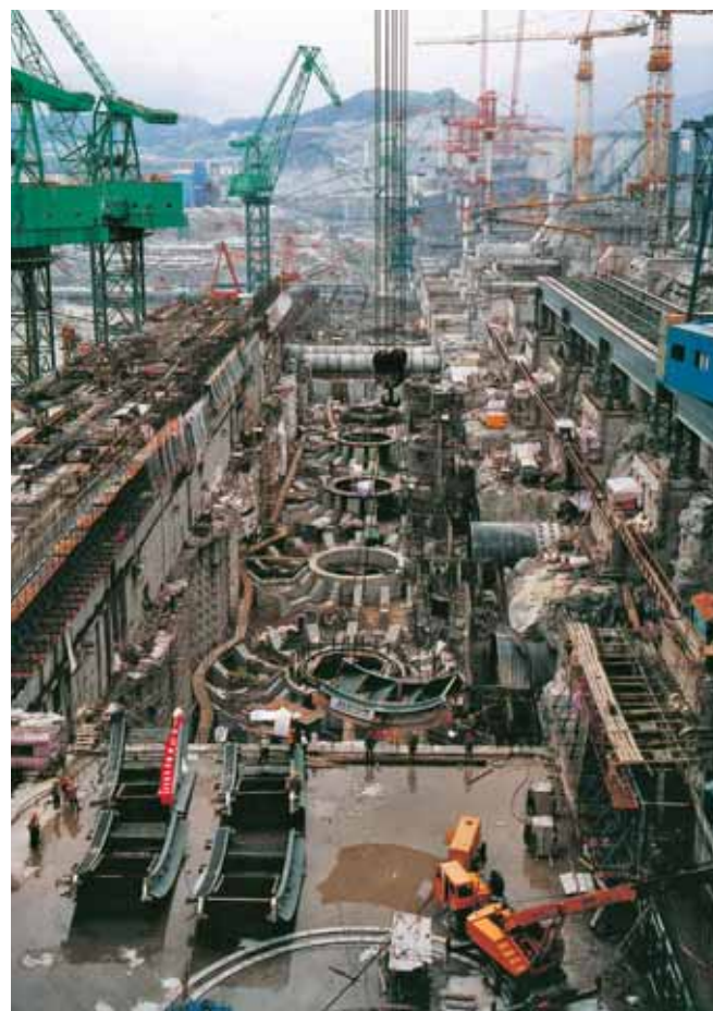
Rys. 15. Zabudowa generatorów turbin na Tamie Trzech Przełomów
