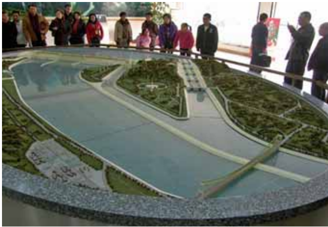
Rys. 11. Makieta tamy (po lewej) i pięciostopniowej śluzy dla statków (po prawej) z windą dla mniejszych jednostek pływających i wydzielonym kanałem (część środkowa)
