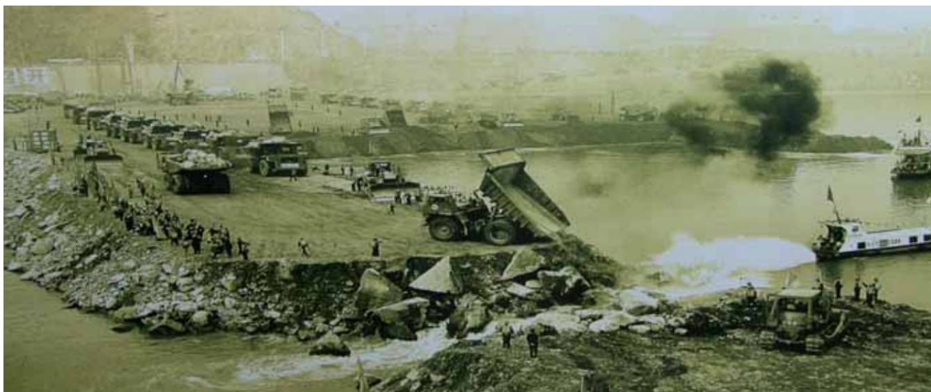
Rys. 8. Ostatni etap przegradzania nurtu Jangcy
