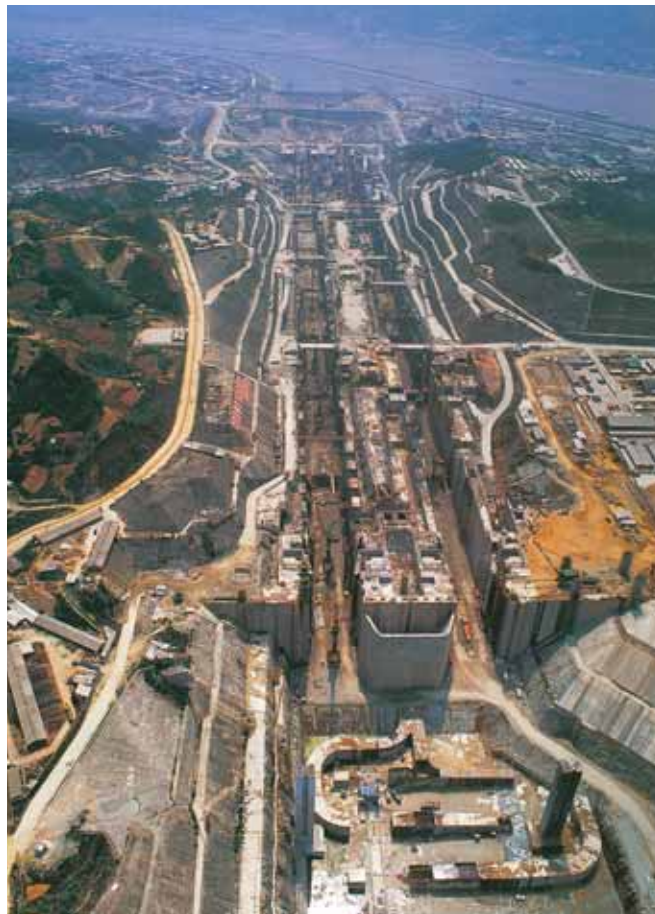
Rys. 14. Budowa pięciostopniowej śluzy na Tamie Trzech Przełomów
