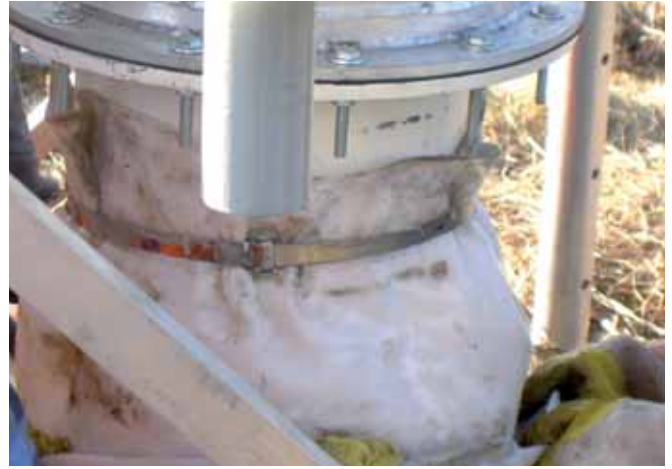
Fot. 3. Wywinięcie rękawa – przygotowanie do wprowadzenia rękawa DN 500
