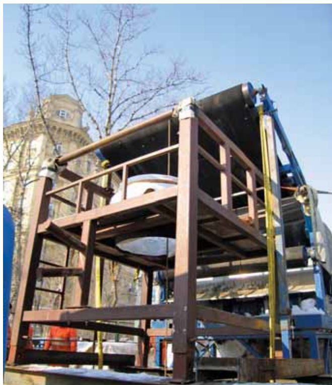
Budowa wieży inwersyjnej do wprowadzenia rękawa
