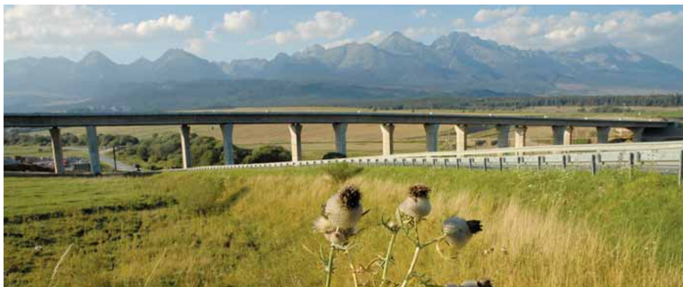
Most na autostradzie D1, Važec - Mengusovce, pod Wysokimi Tatrami
