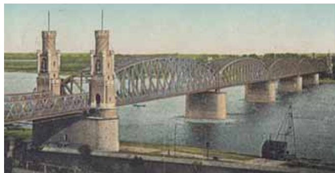
Most kolejowy przez Wisłę w Toruniu na pocztówce wysłanej w 1910 r.
