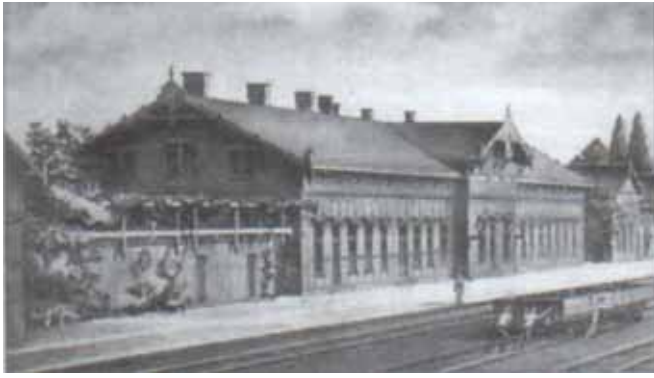
Pierwszy budynek dworcowy na stacji w Toruniu, ok. 1862 r. [1]
