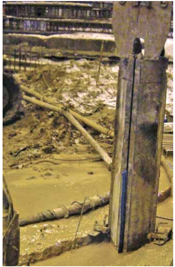
Ryc. 4. Trapezowy element rozdzielczy z uszczelką CWS® zainstalowany w szczelinie przed betonowaniem sekcji
