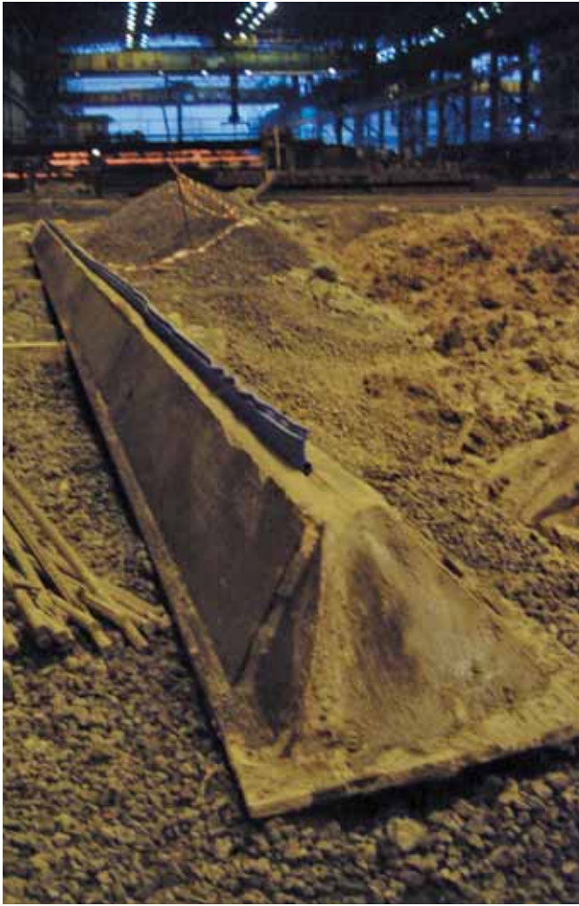
Ryc. 3. Uszczelka CWS® w uchwycie trapezowego elementu rozdzielczego przed zamontowaniem w szczelinie
