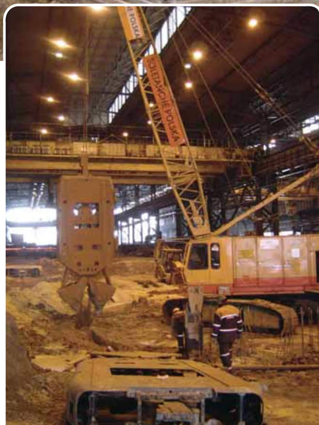
Ryc. 2. Ściana szczelinowa w trakcie drążenia. Roboty w hali, nieopodal trwa wytop stali
