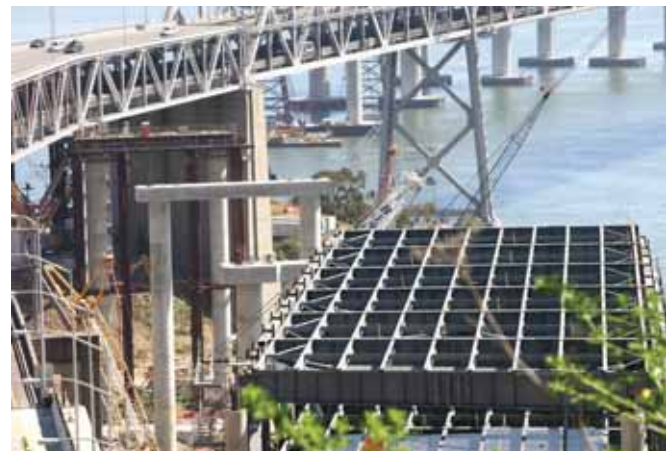
Fundamenty i konstrukcja objazdu w trakcie budowy
