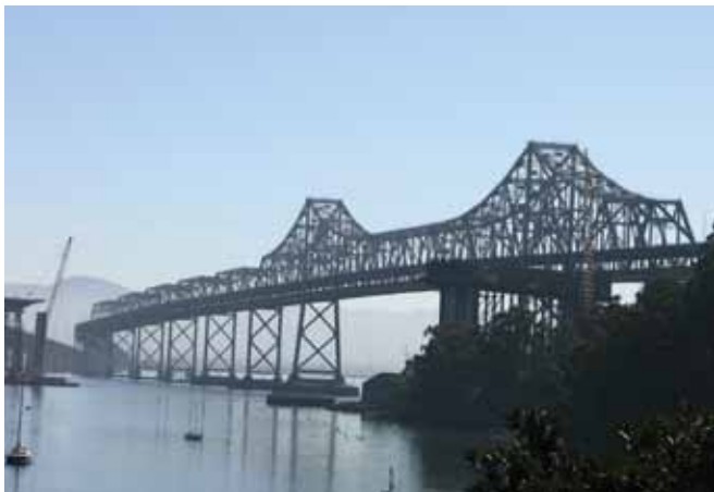
Mosty wspornikowy i kratownicowy po wschodniej stronie wyspy Yerba Buena
