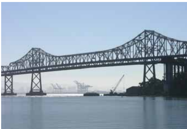
Wspornikowa część mostu Bay Bridge
