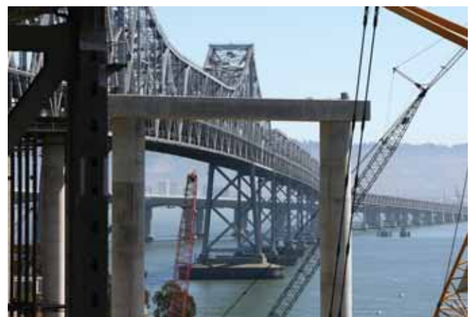
Podpora tymczasowego objazdu
