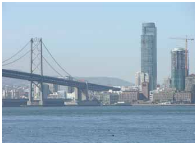
Fundament kotwiący po stronie San Francisco
