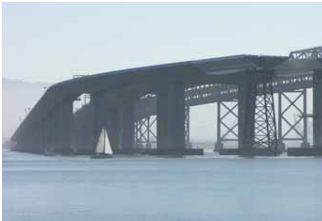
Nowa konstrukcja skyway ukończona w 2007 r.
