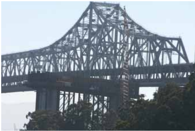
Fundamenty W2 zakotwienia mostu SAS
