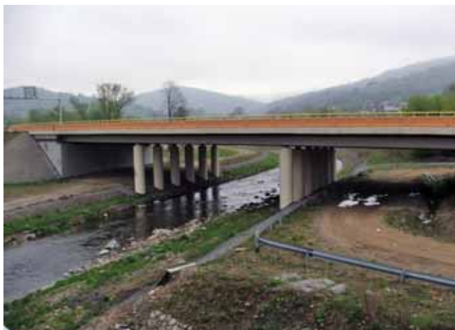
Wiadukt w Pcimiu, fot. NBI
