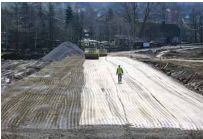
Budowa autostrady A-4, fot. Egis Poland Sp. z o.o.
