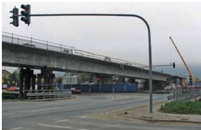
Budowa estakady w Myślenicach, fot. NBI
