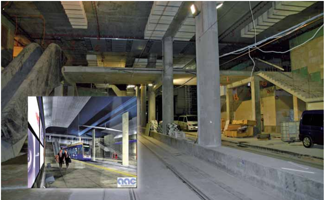
Przystanek Politechnika – w trakcie budowy i na wizualizacji
