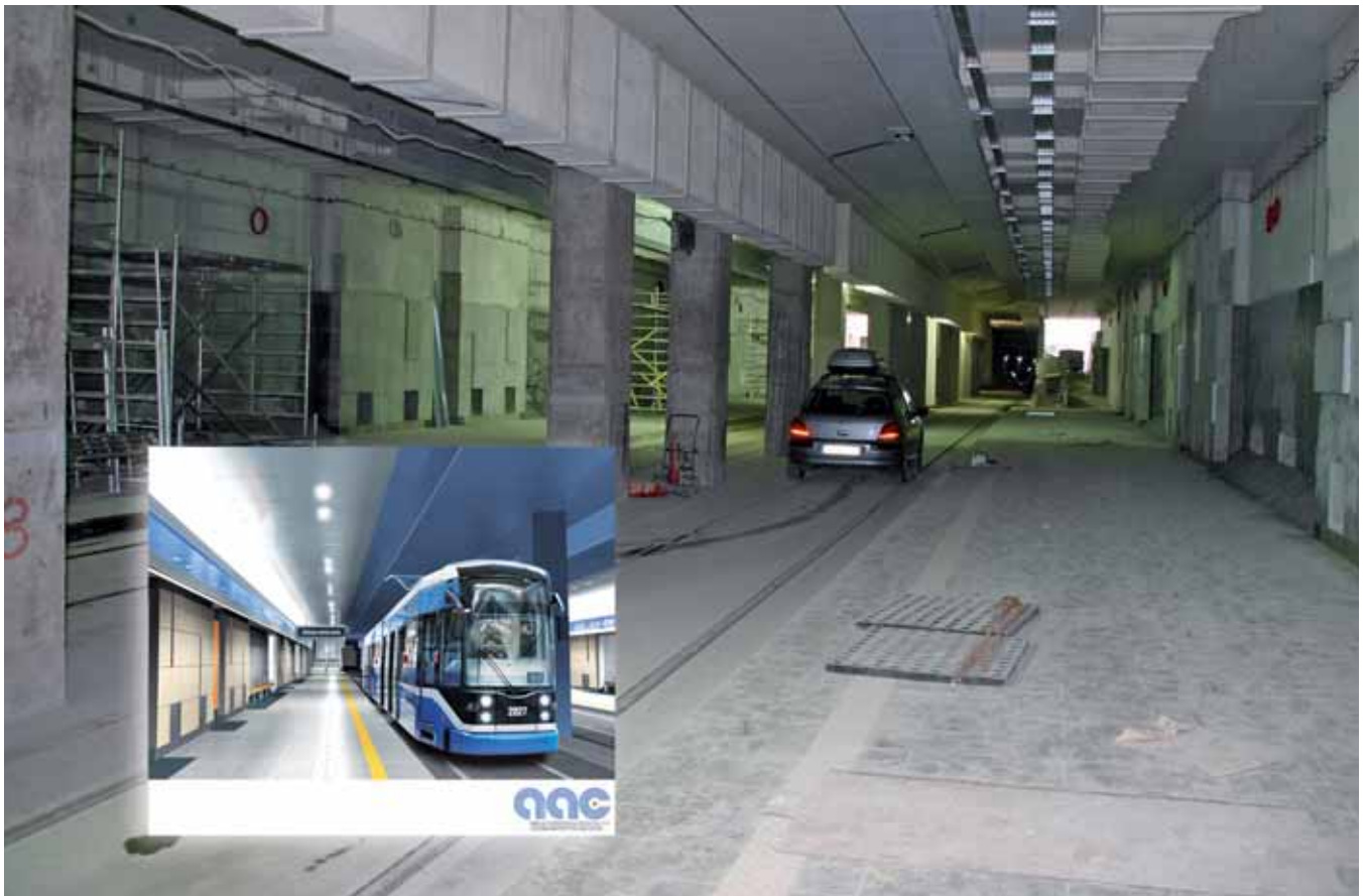
Przystanek Dworzec Główny – w trakcie budowy i na wizualizacji
