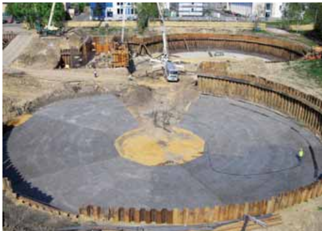
Wykop pod osadniki wtórne powstające na miejscu basenu fermentacyjnego
