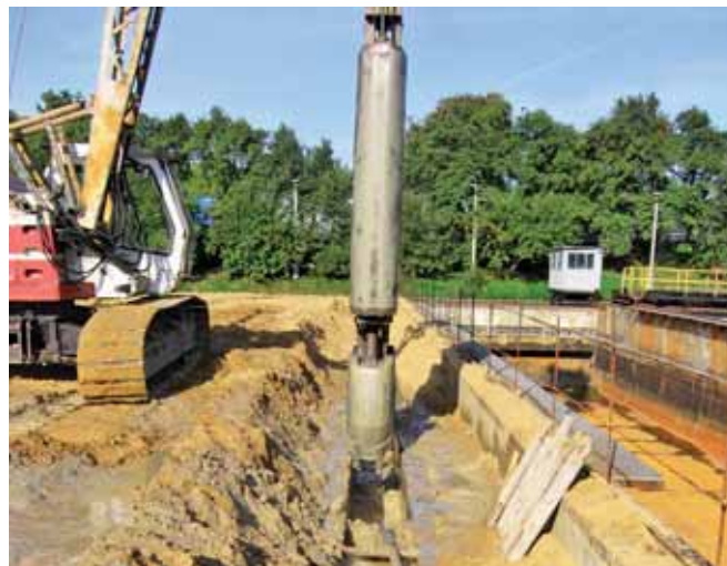
Realizacja ścian piaskownika
