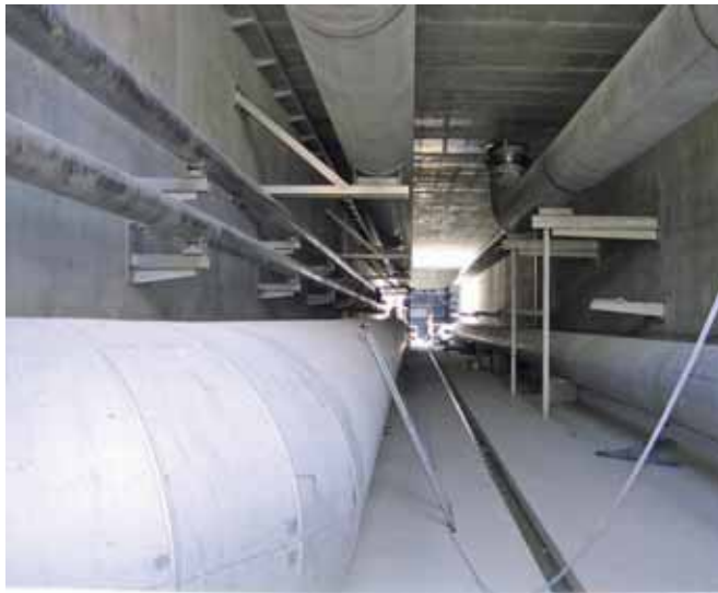
Wnętrze kanału technologicznego
