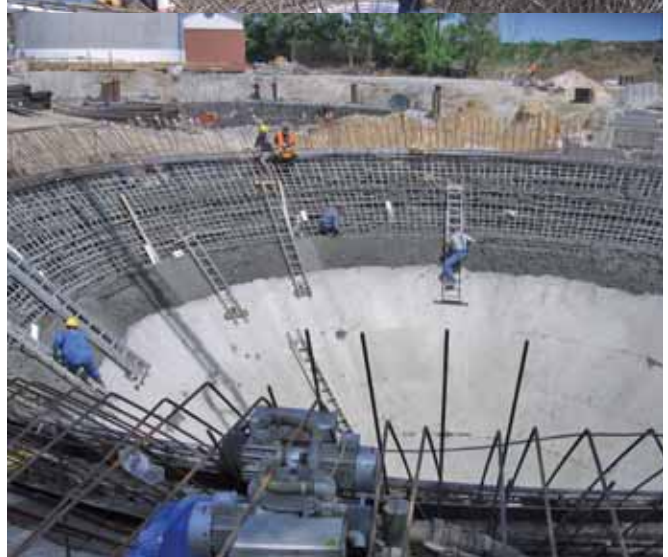
Realizacja płyt dennych ZKF-ów
