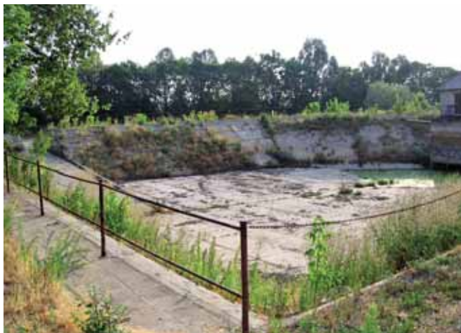
Basen fermentacyjny do rozbiórki
