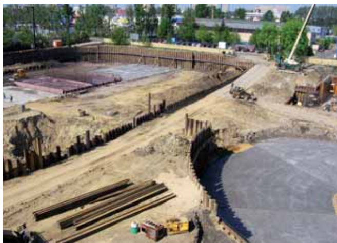
Wykop pod bioreaktory powstające na miejscu basenu fermentacyjnego
