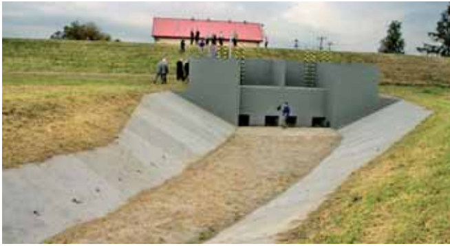
Komora wlotowa przepompowni P-2 „Baška” wraz z fragmentem przebudowanego kanału odpływowego
