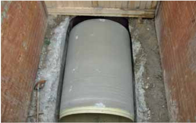
Panele w wykopie
