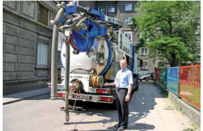
Sprzęt specjalistyczny do renowacji kanalizacji, os. Centrum A w Nowej Hucie
