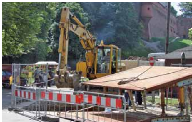
Renowacja panelami kanału przelazowego ul. Podzamcze
