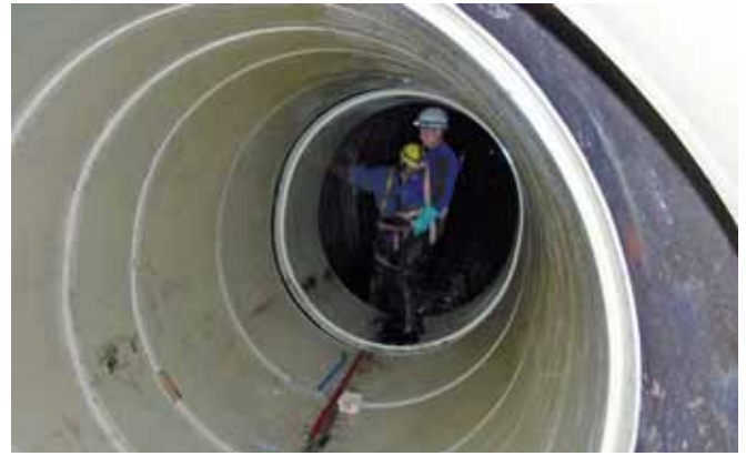
Wykonawca remontuje panelami w ul. Podzamcze
