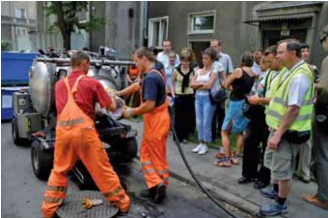
Renowacja kanalizacji nieprzelazowej przy pomocy rękawa, os. Centrum A
