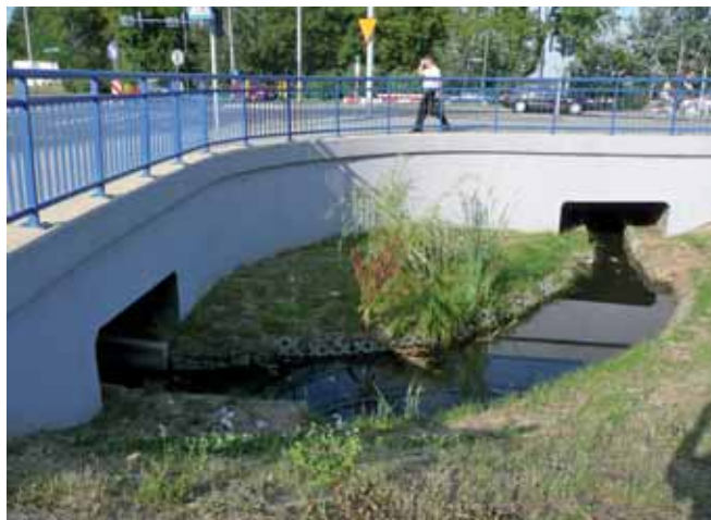
Ryc. 9. Przykład żelbetowych przepustów ramowych zrealizowanych w ostatnich latach we Wrocławiu, fot. J. Howis
