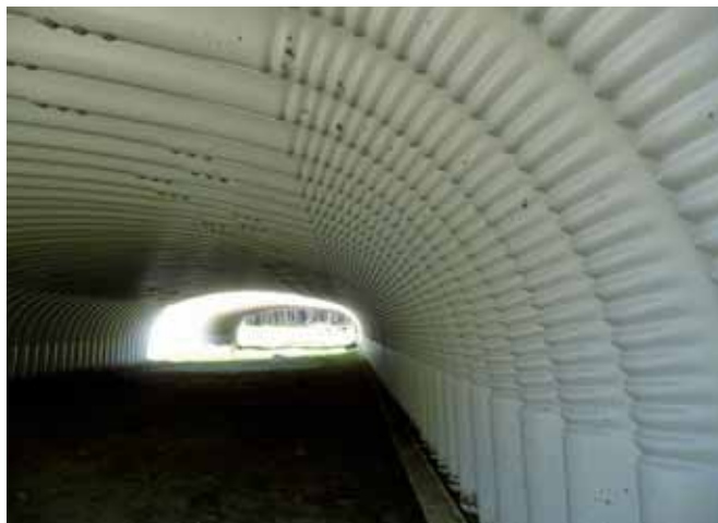
Ryc. 10. Przykład rozwoju konstrukcji gruntowo-powłokowych z blach falistych w kierunku zwiększenia rozpiętości i nośności (konstrukcja SuperCor zastosowana jako przejście dla zwierząt pod drogą S3), fot. A. Wysokowski
