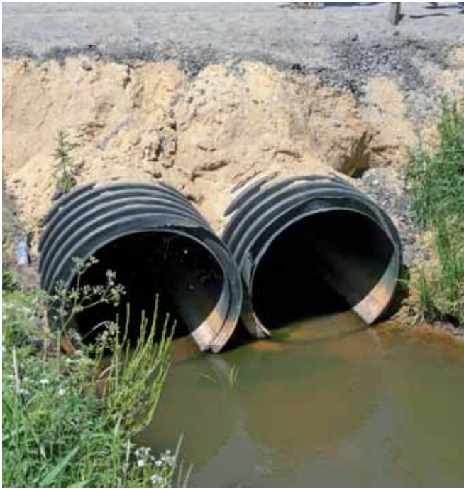
Ryc. 14. Lekkie rury osłonowe z PEHD zastosowane do budowy drogi tymczasowej podczas budowy drogi ekspresowej S3, fot. A. Wysokowski
