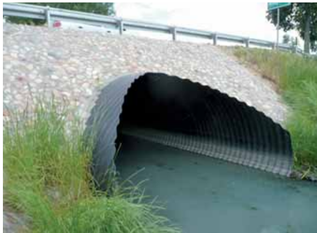
Ryc. 8. Przykład ostatnio zrealizowanej konstrukcji gruntowo-powłokowej z blach falistych na terenie Wielkopolski, fot. A. Wysokowski
