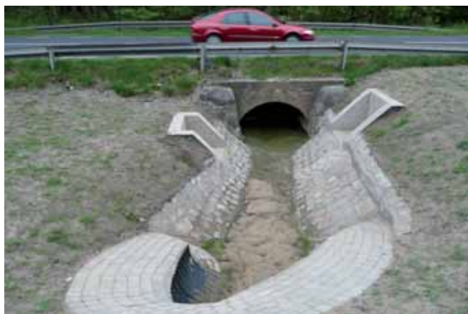
Ryc. 1. Porównanie przepustu tradycyjnego i nowoczesnego – z blach falistych (w ciągu modernizowanej drogi ekspresowej S3), fot. A. Wysokowski
