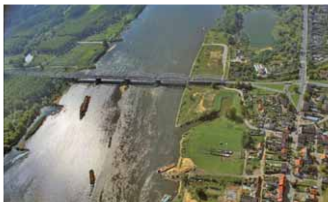
Widok mostu przez Wisłę w Fordonie z lotu ptaka
