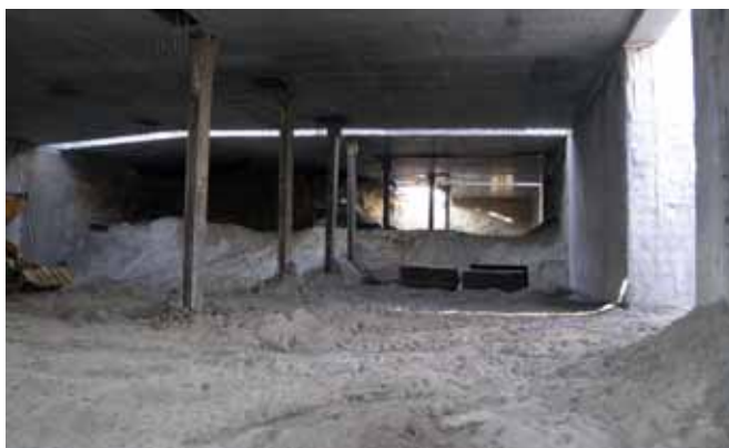
Widok części podziemnej stacji w trakcie realizacji wykopu podstropowego
