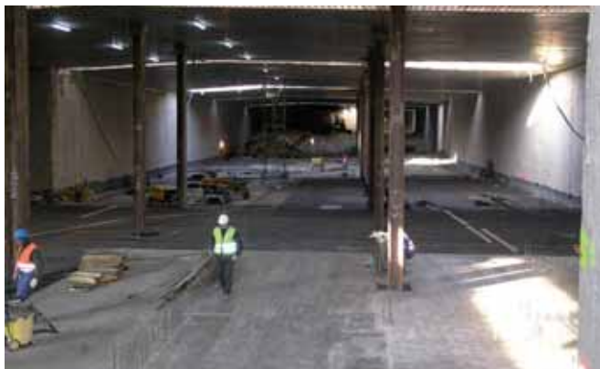
Widok części podziemnej stacji w trakcie fazowania wykonania płyty dennej
