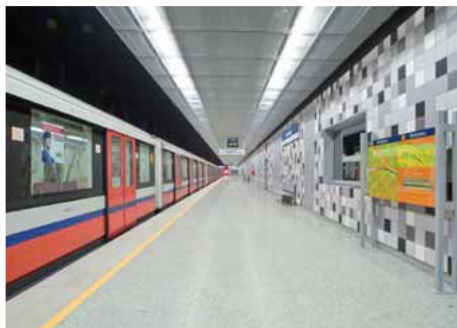
Widok części podziemnej stacji
