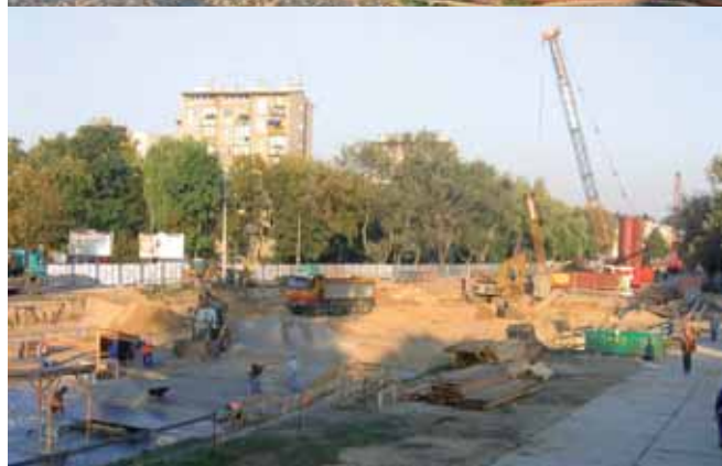
Widok płyty stropowej w trakcie realizacji
