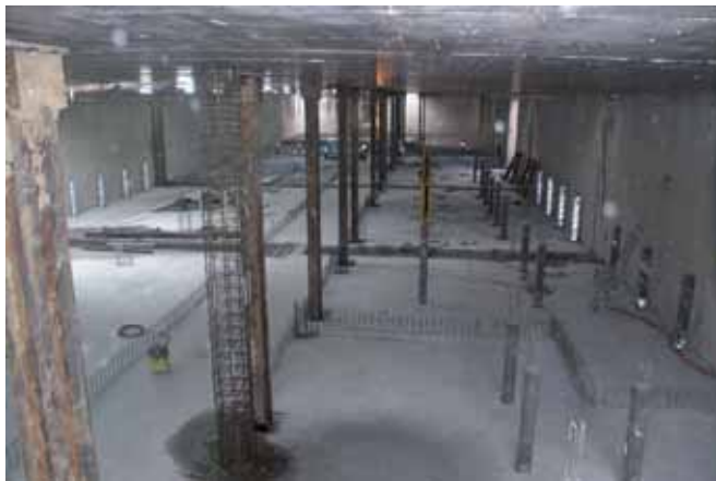
Płyta denna z podziałem na przerwy technologiczne
