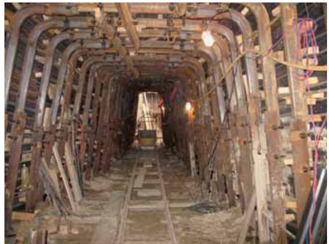
Budowa tunelu metodą górniczą
