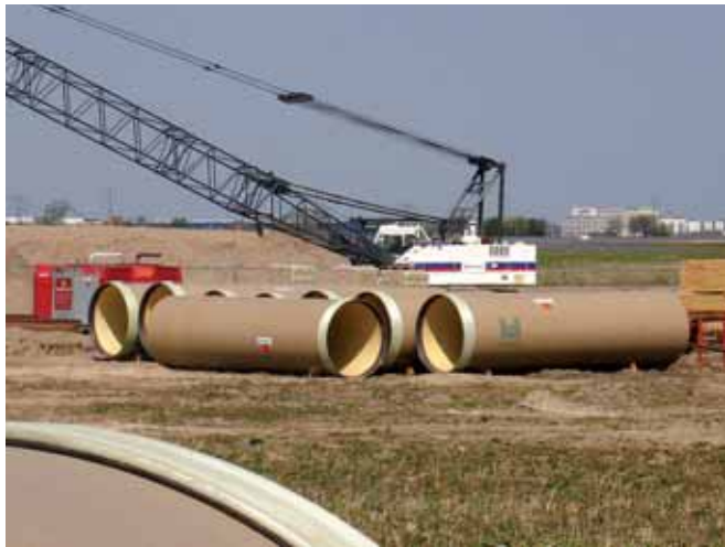
Budowa odwodnienia na lotnisku Berlin-Schönefeld
