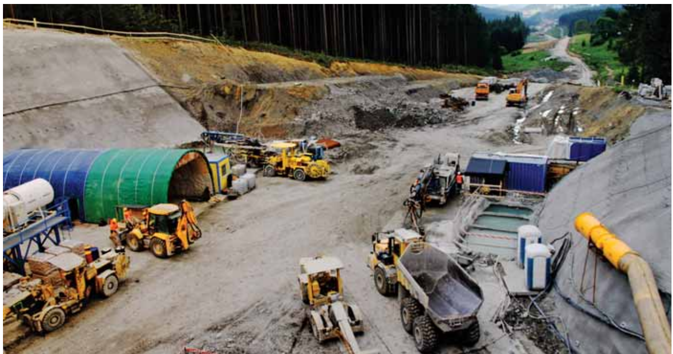
Budowa tunelu w Lalikach
