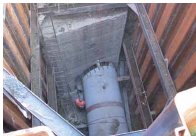
Przyłączenie nowo budowanego kanału DN 1400 do istniejącej komory żelbetowej
