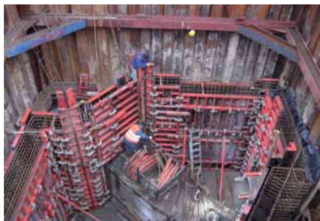
Deskowanie ścian studni na skrzyżowaniu kanału istniejącego z nowo budowanym
