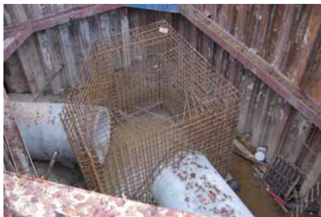
Zbrojenie ścian studni
