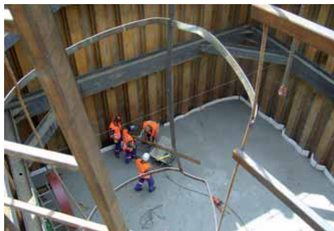
Betonowanie dna studni
