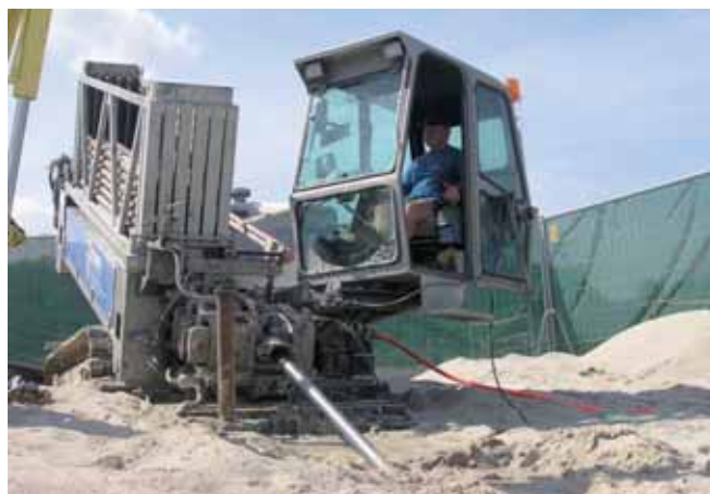
GrundoDRILL 15N podczas instalacji rury
