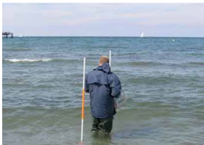
Pomiar prowadzonego przewiertu pilotowego
