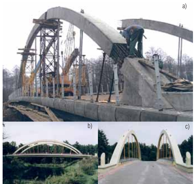
Ryc. 2. Most drogowy nad Piśą w Puszczy Piskiej: a) widok na montaż styków łuków, b) widok z boku, c) widok z osi drogi
