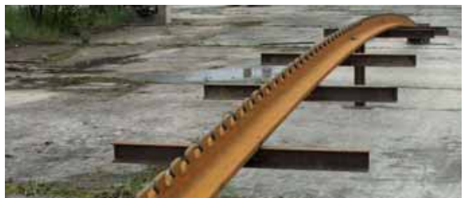
Ryc. 13. Kładka dla narciarzy w Przemyślu – część stalowa dźwigara
