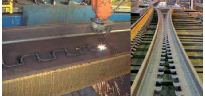
Ryc. 10. Wiadukt drogowy w Vigaun – cięcie dźwigarów stalowych
