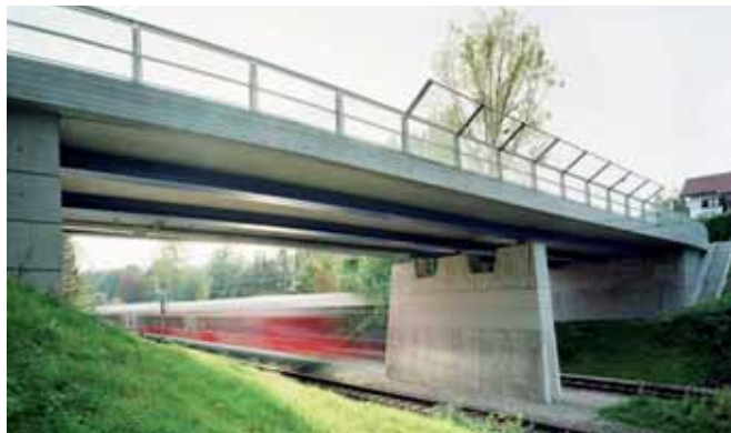
Ryc. 7. Wiadukt drogowy w Pöcking – widok ogólny obiektu
