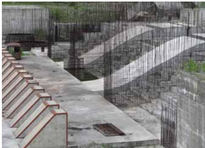
Zapora w budowie na rzece Olt
