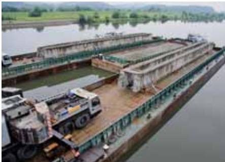
Ryc. 13. Zabezpieczenie dźwigów i belek balastowych na barkach
