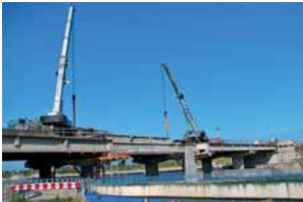
Ryc. 10. Demontaż belek WBS
