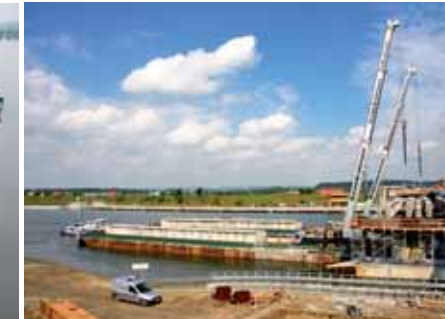
Ryc. 14. Barki w czasie demontażu belek WBS
