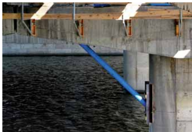
Ryc. 3. Wzmocnienie filaru mostu – lewa jezdnia (kierunek Balice)
