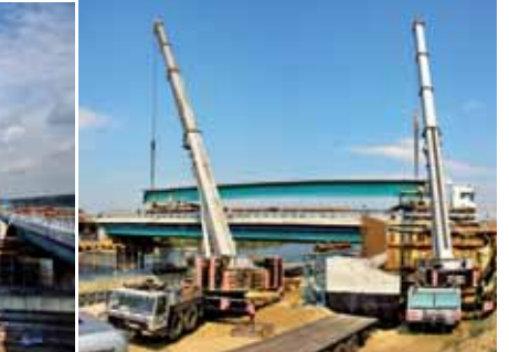
Ryc. 15. Montaż ostatniego przęsła belek VFT®
