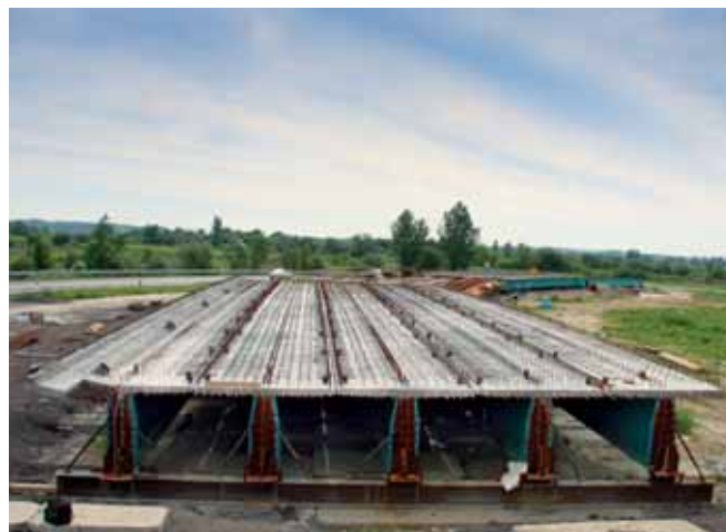
Ryc. 4. Belki VFT® na polu prefabrykacji
