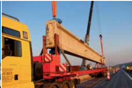
Ryc. 11. Transport dźwigarów WBS
