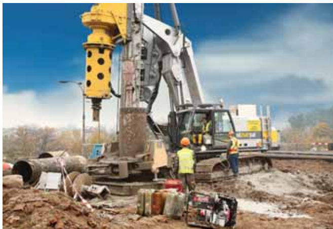
Mostmarpal na budowie Stadionu Narodowego w Warszawie
