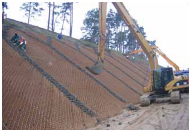
Instalacja systemu Neoweb
