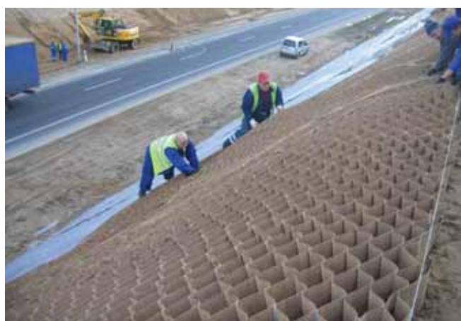
Stabilizacja skarp gorzowskiej obwodnicy
