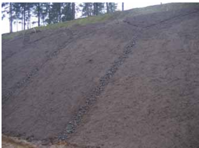
Widok zabezpieczonej skarpy
