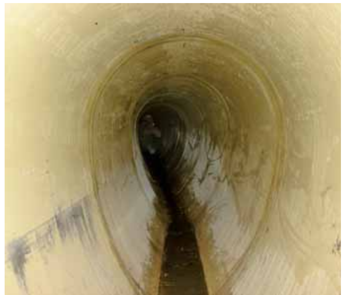
Ryc. 5. Ul. Franciszkańska w Krakowie – kanał po renowacji panelami GRP
