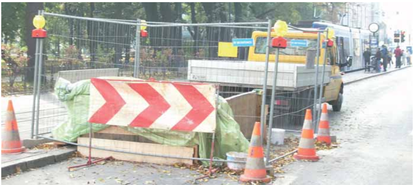
Ryc. 3. Ul. Franciszkańska w Krakowie – wykop startowy
