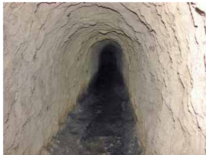
Ryc. 2. Ul. Franciszkańska w Krakowie – kanał przed renowacją
