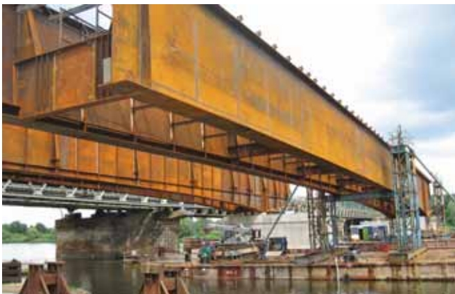
Montaż konstrukcji stalowej – most na Regalicy
