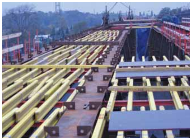
Deskowanie płyty mostu na Odrze
