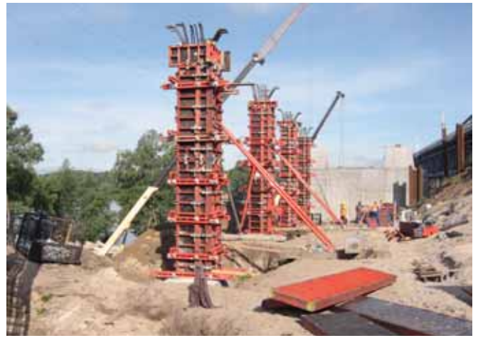
Montaż szalunków słupów estakady dojazdowej WDO
