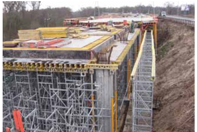
Deskowanie płyty estakady WDR
