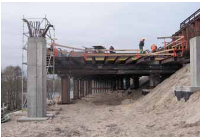
Deskowanie płyty estakady WDO
