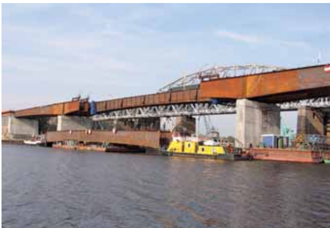
Transport konstrukcji stalowej na Odrze
