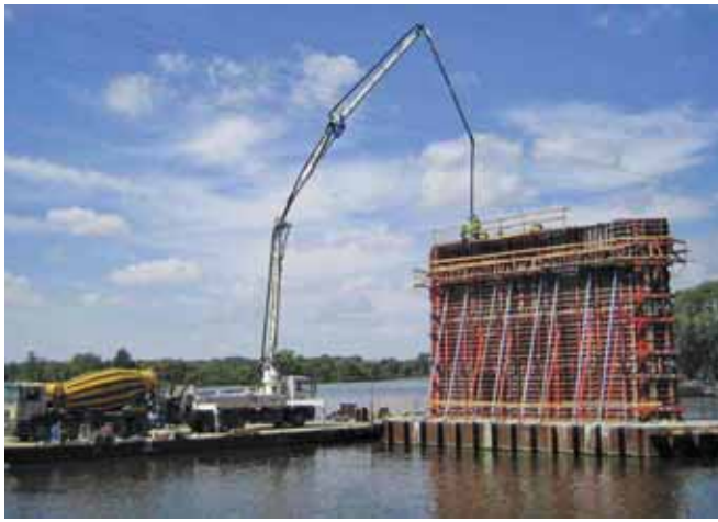
Betonowanie podpory nurtowej – most na Odrze
