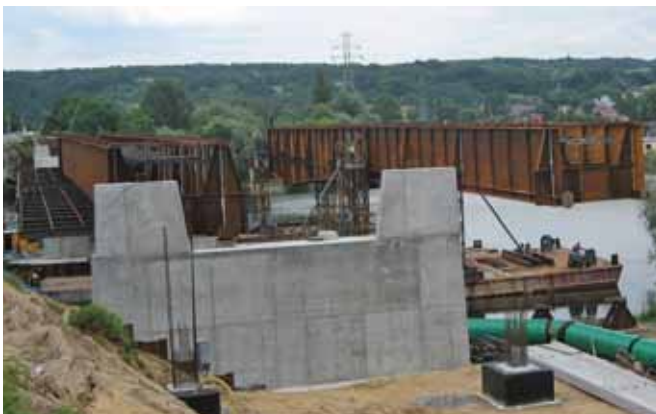
Montaż konstrukcji stalowej – most na Regalicy
