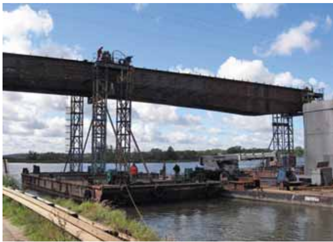
Montaż konstrukcji stalowej
