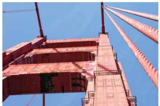
Falowe osłony blachowe i stopniowane podparcia portali, fot. K. Dąbrowiecki
