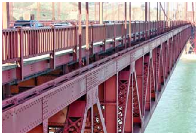
Kratownica usztywniająca przęsło główne, fot. K. Dąbrowiecki
