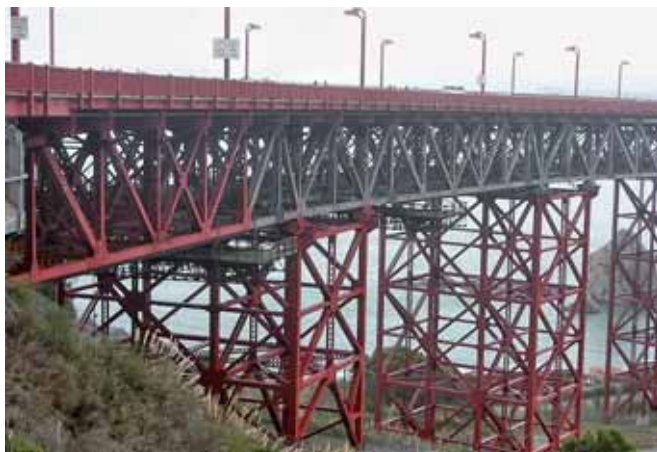
Kratownice usztywniające i podpierające po stronie północnej, fot. K. Dąbrowiecki
