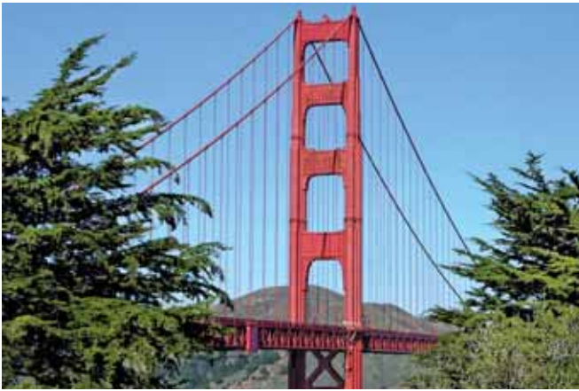
Pylon południowy, fot. K. Dąbrowiecki
