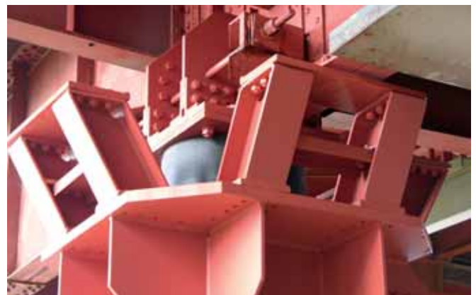
Zabezpieczenie antysejsmiczne pomiędzy kratownicą i kolumną, fot. K. Dąbrowiecki
