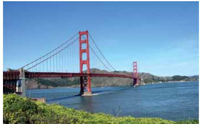
Widok mostu od strony południowej, fot. K. Dąbrowiecki
