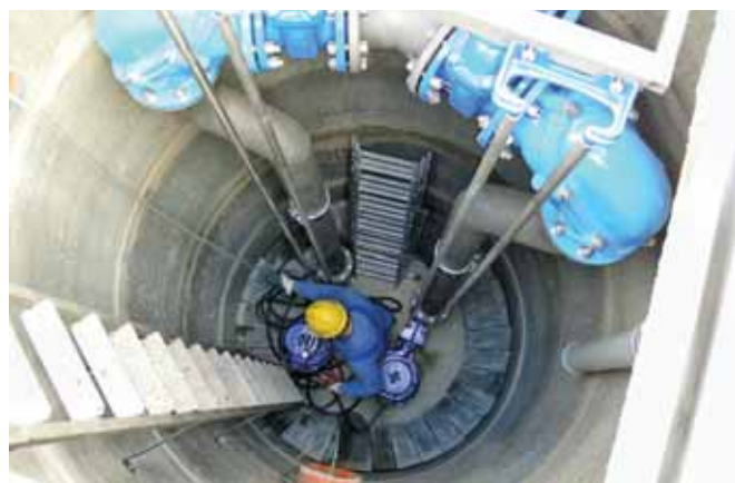
Montaż przepompowni typu PSD.2 produkcji Hydro-Vacuum SA w miejscowości Nowe Marzy
